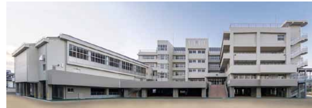
▲津波避難ビルとして活用できる市内初の高床式の沖洲小学校新校舎が開校し、安全で快適な学校生活スタート (1月)
