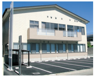
▲新しく完成した住吉・城東コミュニティセンター
