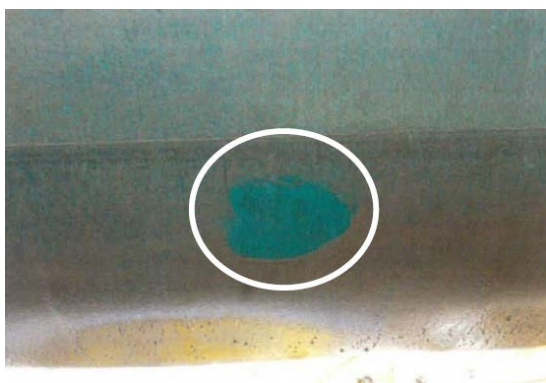
写真4 土嚢が接していた部分
