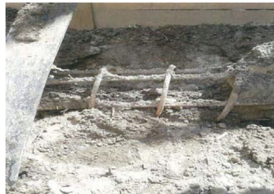
写真 3 支柱の下部の状況
