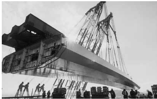
起重機船「海翔」による作業 (2020.12.5)
