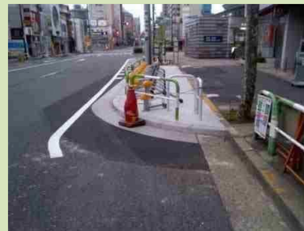
東京都豊島区新大塚駅周辺における 歩道を一部拡幅しての駐輪施設設置例 【出典：自転車等駐車場の整備のあり方に関する ガイドライン】
