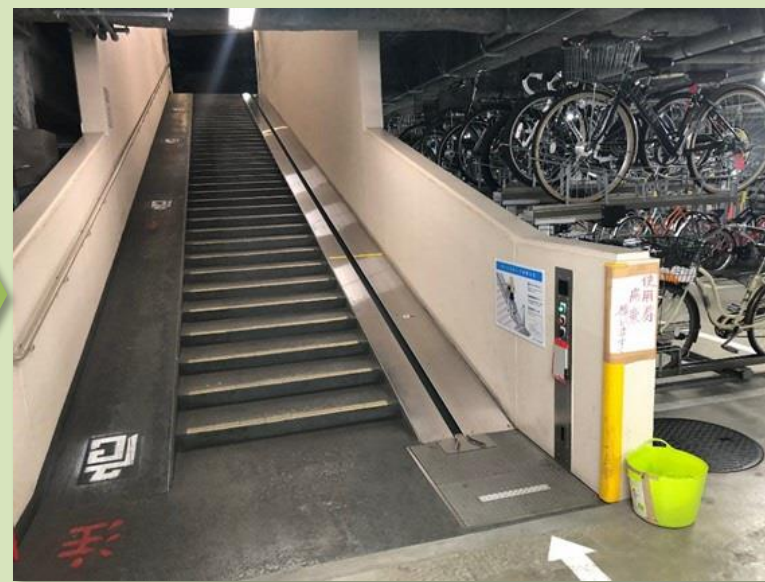
サイクルスロープの設置例 （千葉県市川市ターミナルシティ本八幡地下駐輪場）
