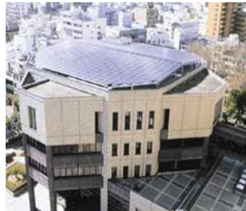
徳島市庁舎太陽光発電システム
