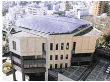
徳島市庁舎太陽光発電システム
