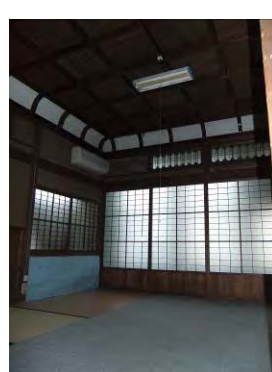
折り上げ格天井
